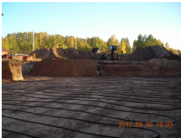
Рис. 1. Прокладка горизонтального подземного контура низкопотенциального источника тепла.
